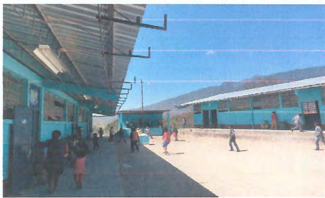
Foto 1: Mejorar canales bajadas de agua escuela nueva
