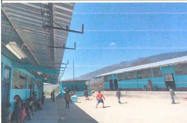
Foto 3: Remosamiento estructura de techo de patio
